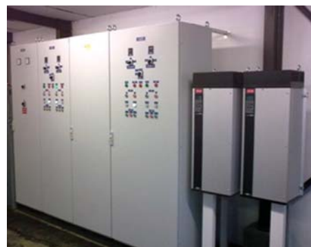
Új vezérlőszekrény a frekvenciaváltókkal
