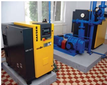
Új csavarkompresszor és forgódugattyús fúvó
