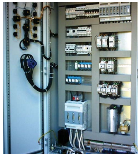
Csápos I. kút új vezérlőszekrénye
