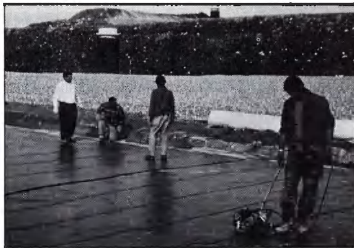
Valahol Németországban. Készül a mesterséges aljzatszigetelés.
